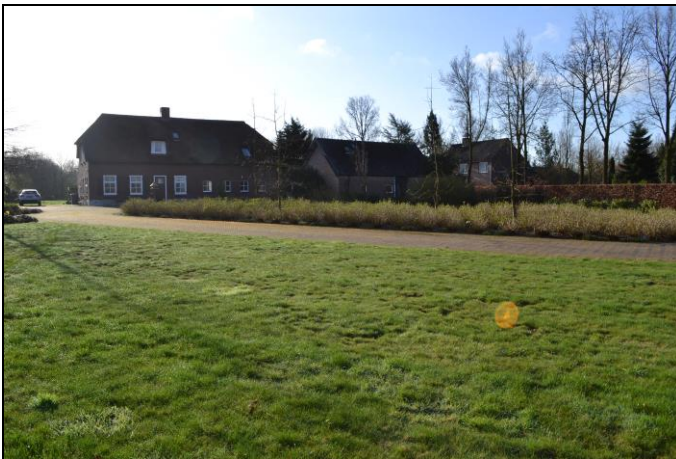
Figuur 2a: Het plangebied bij aanvang van de werkzaamheden in zuidoostelijke richting.
